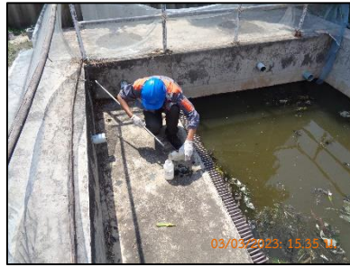
บ่อฟักน้ำเสียก่อนไหลเข้าสู่บ่อสูบของระบบบำบัดน้ำเสียรวม
